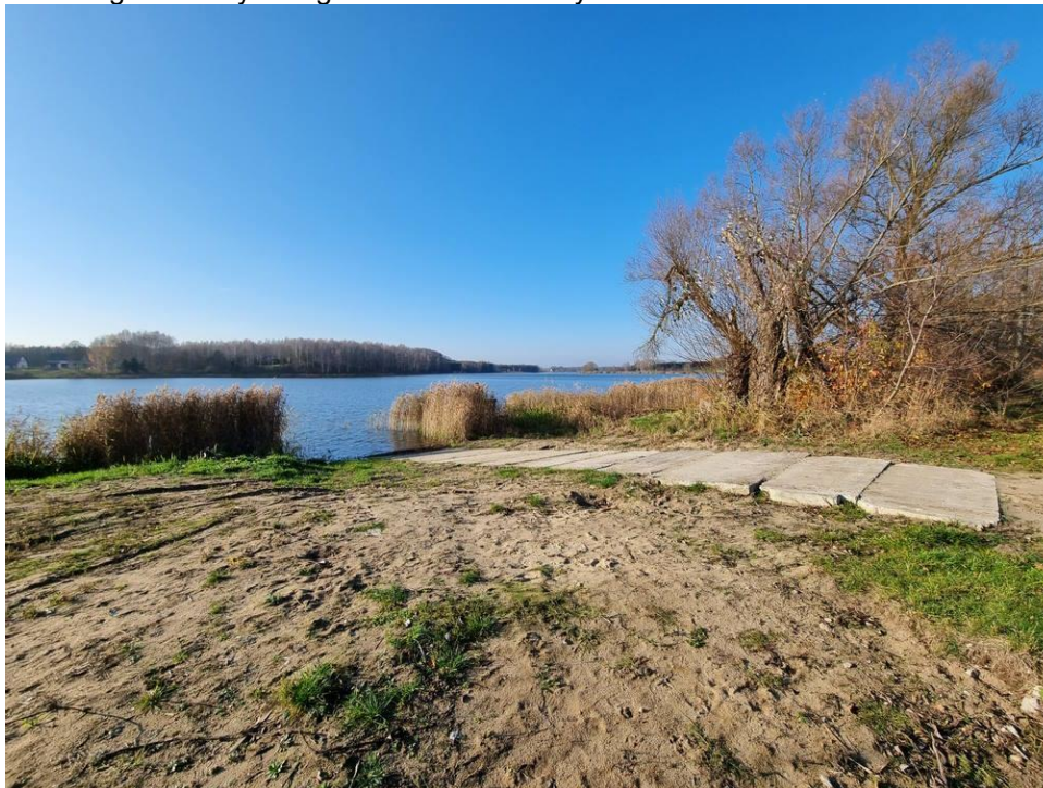
Fotografia 13. Zdegradowany brzeg Zalewu w Drzewicy
